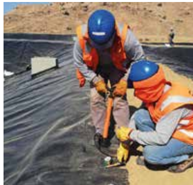
02 Instalación de Geosintéticos HDPE
